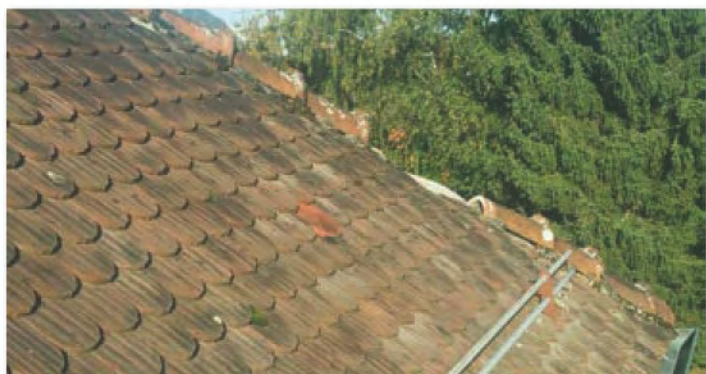
C'est une entreprise locale, Fabrice Cornu ferblanterie-couverture à Versvey, qui s'est chargée des travaux
