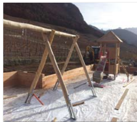
La future place de jeux au mois de novembre, en pleins travaux.
