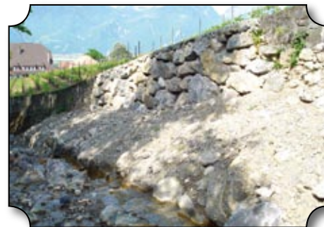
Consolidation des murs de vigne
