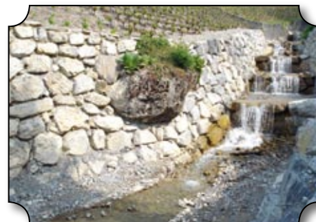
Enrochement rive droite
