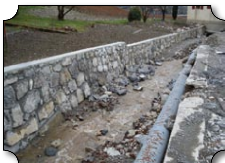
Mur rive gauche reconstruit
