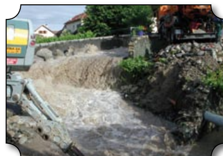
Route de la Scie, remise du torrent dans son lit
