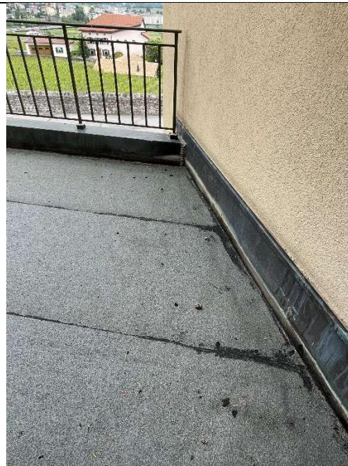
PHOTO 2: ETANCHÉITÉ DE LA TERRASSE 2
