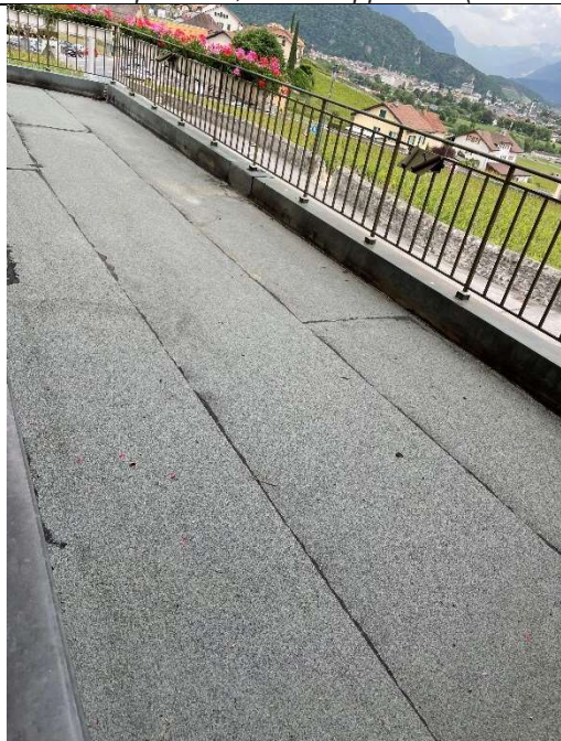
PHOTO 1: ETANCHÉITÉ DE LA TERRASSE 1
