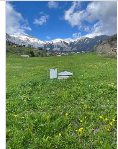
FIGURE 4: LE DÔME MÉTALLIQUE, VUE EXTÉRIEUR DE LA CHAMBRE DE ROUTE-TERRE
