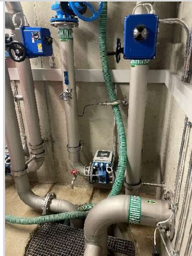
FIGURE 2: VUE SUR LA ZONE DE DÉCHARGE
