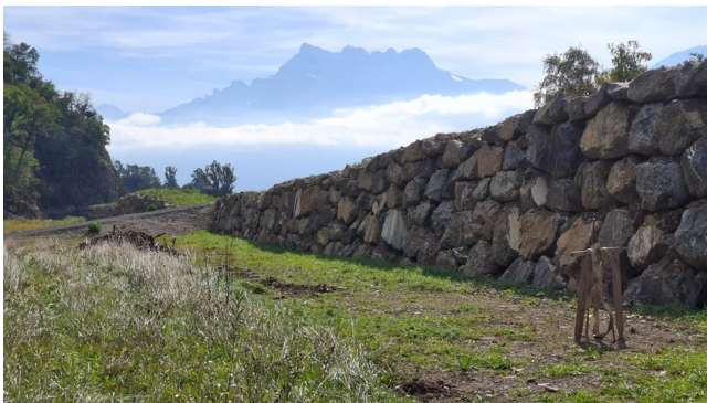
Digue 4 terminée - octobre 2025
