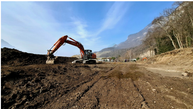
Excavation de la digue 4 : février 2025
